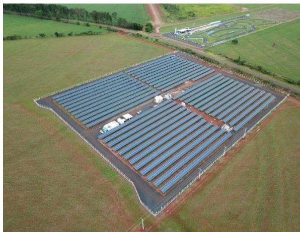
Figura 6.15 Foto da aérea da planta fotovoltaica
